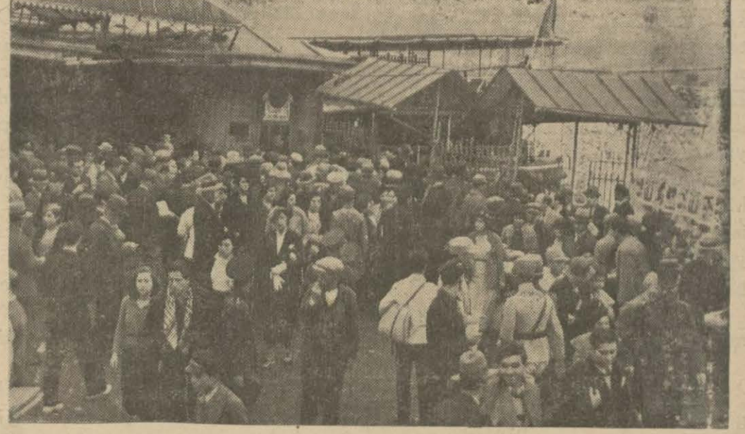
Şimdiki Kadıköy iskelesi
